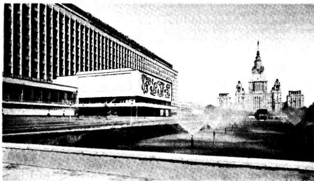
Рис. 34.38. Высотное здание Московского университета. На переднем плане — корпус гуманитарных факультетов
