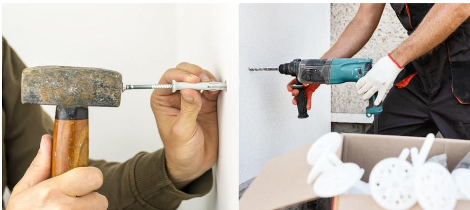
Немаловажное значение играют длина дюбеля и его диаметр, а также усилие, действующее на крепление: усилие на вырыв, усилие на срез и изгибающий момент. К примеру, вырывающее усилие максимально действует по оси дюбеля. Усилие на срез активно воздействует при креплении на стену. Изгибающий момент проявляется при воздействии нагрузки на крепление на некотором расстоянии от базового материала (например, консольное крепление).
